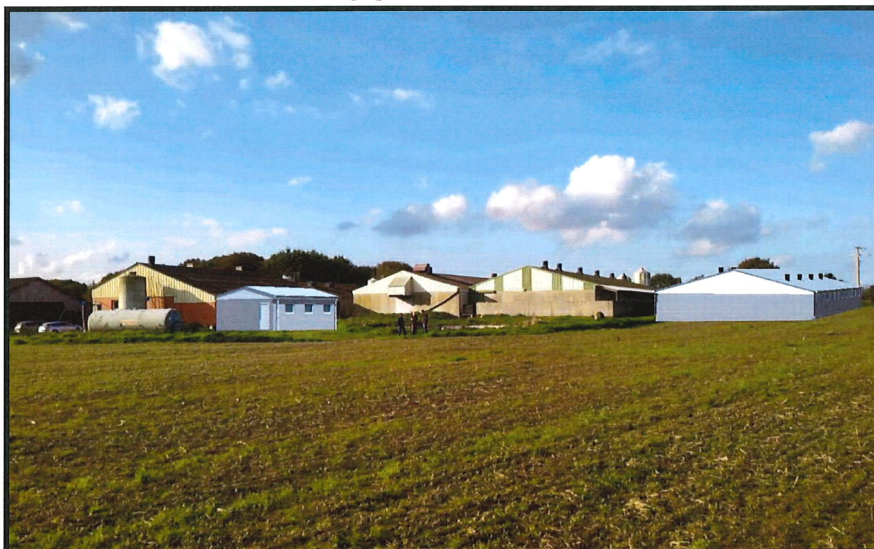
Photographie 6 : vue après travaux
